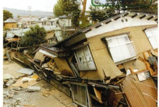
木造二階建て住宅(在来工法)の場合日本では、阪神淡路大震災を教訓として法改正が行われ、地震にも安心な建物が建てられるようになりました。しかし、それは品確法でいう耐震等級Ⅰ～ⅢのうちのⅠに過ぎません。耐震等級ⅢはⅠの1.5倍もの強度があります。今では建築基準法をはるかに超える大地震が起きています。耐震等級Ⅰは建築基準法の最低ラインでしかなく、命さえ助かればよいという最低レベルの強度基準なのです。
